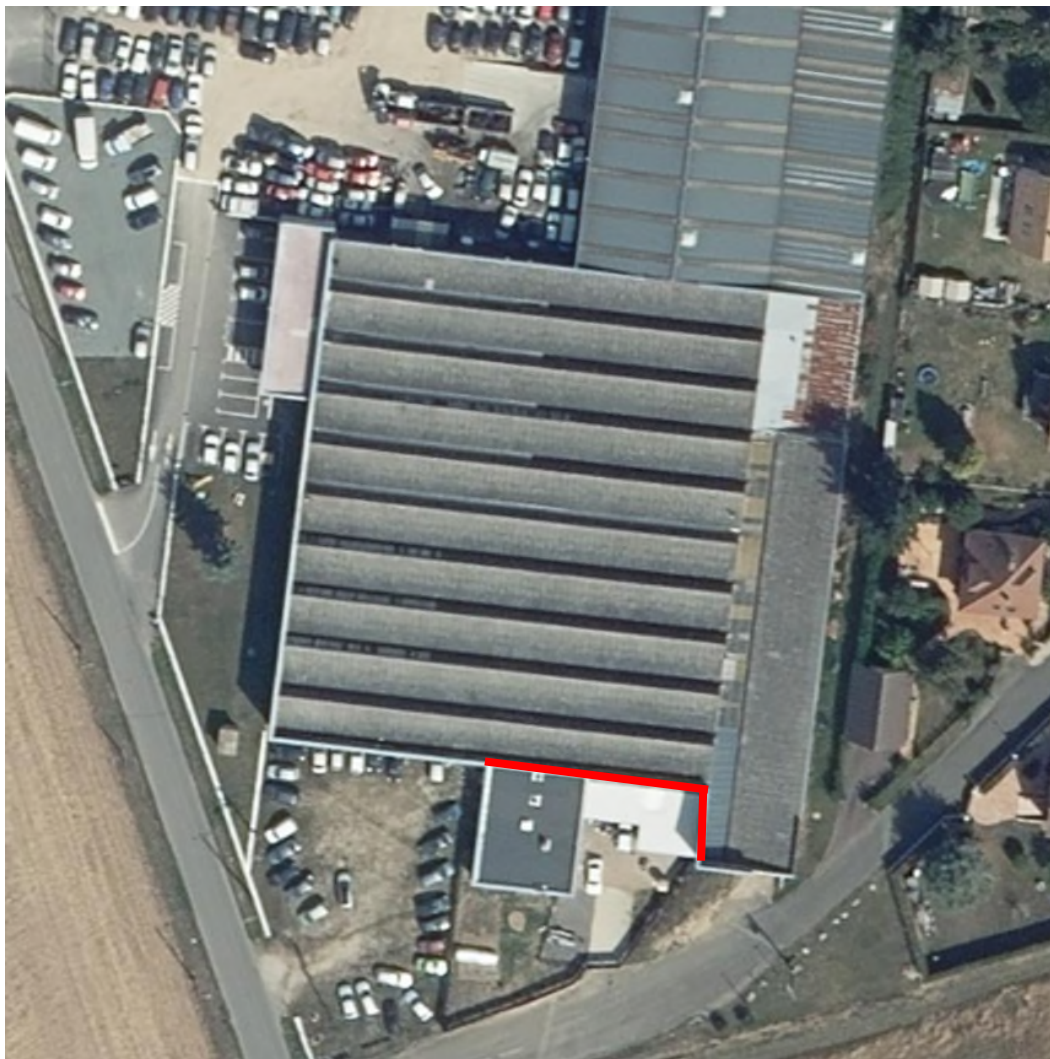
Mur séparatif devant être rendu coupe-feu par flocage
