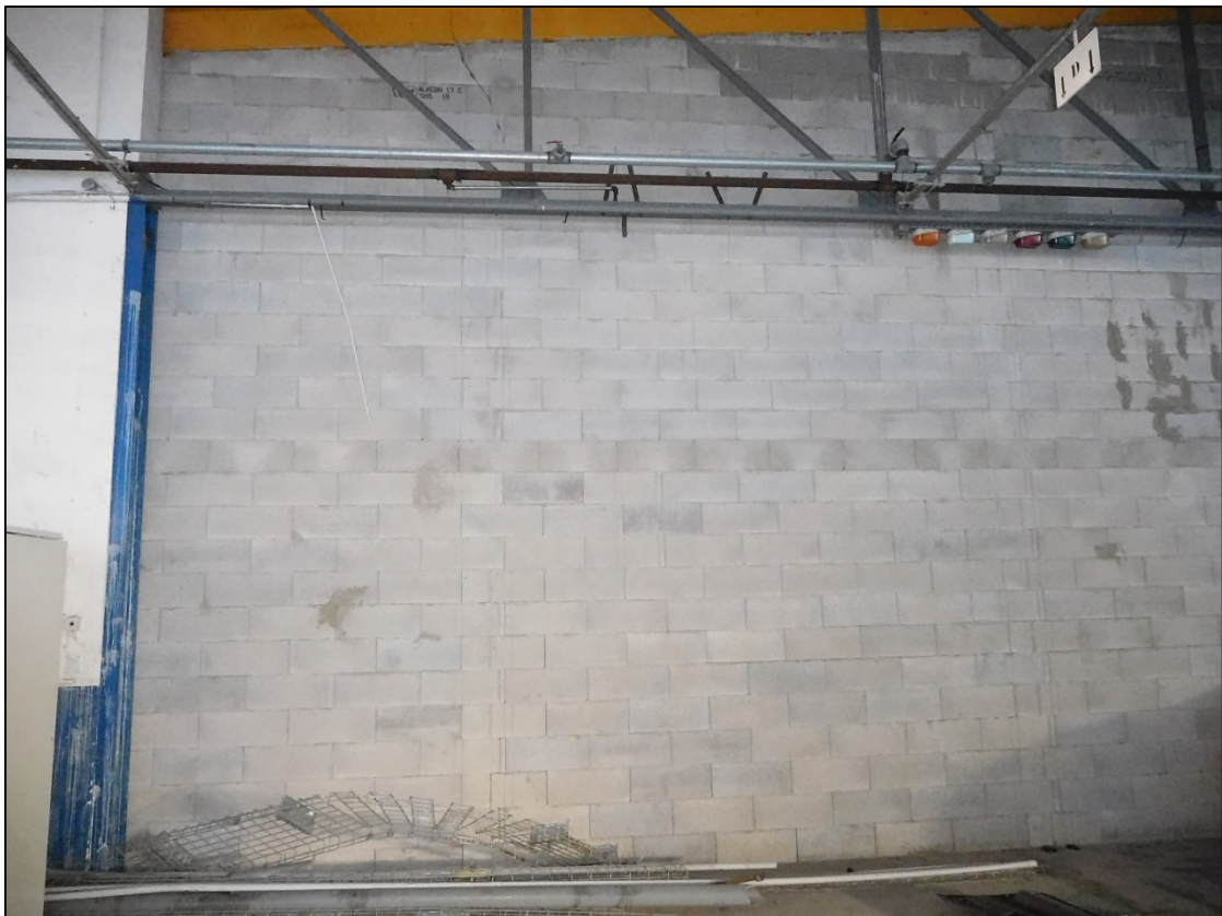
Mur séparatif du bâtiment principal
